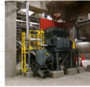
破砕機に投入する
